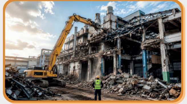
Ömrünü Tamamlamış Fabrika Sökümü
